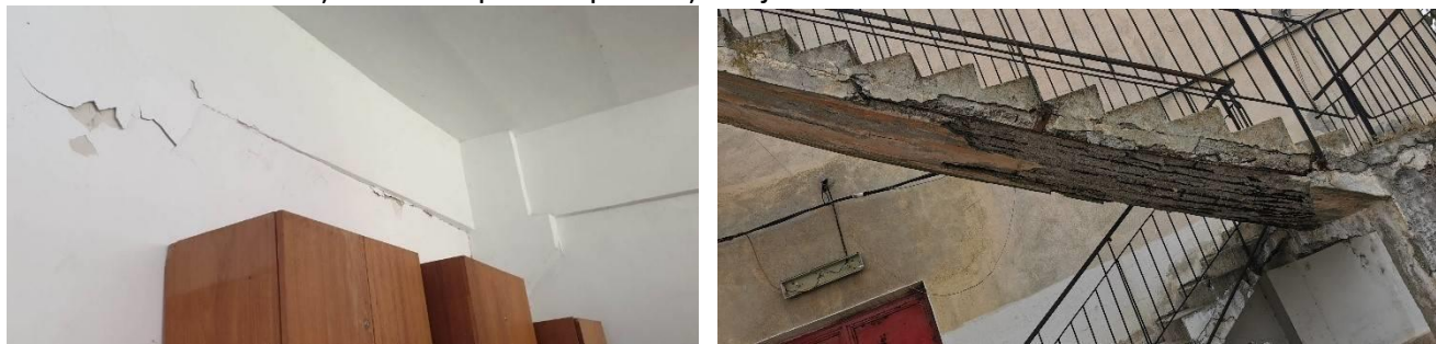
Figura 4 Clădirea administrativă C1 a SPB
